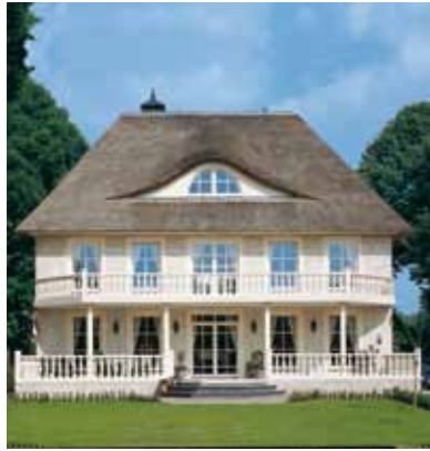
Kozijnen zijn dominante vormgevingselementen
